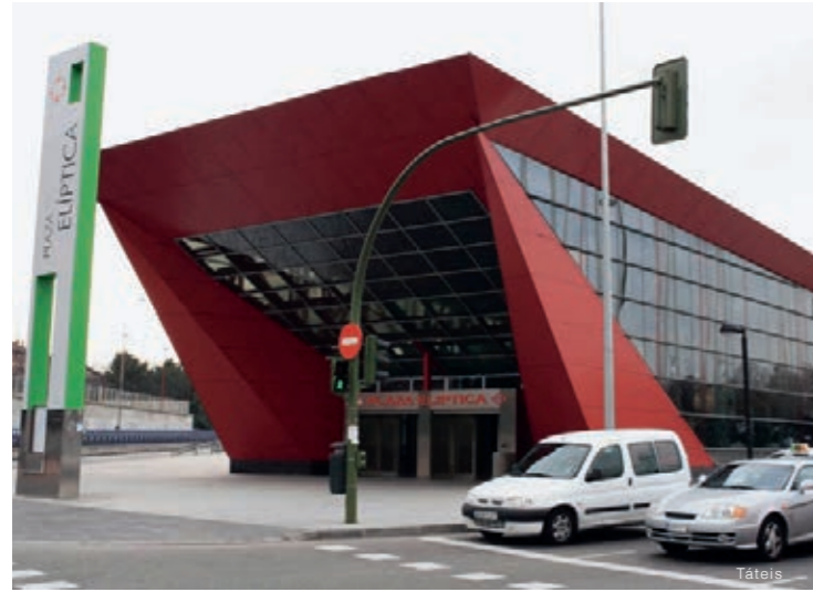
Estação de Metro "Plaza Elíptica" _ Madrid, Espanha Plaza Elíptica Underground Station _ Madrid, Spain
