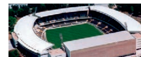
Estádio D. Afonso Henriques (Vitória Sport Clube de Guimarães) _ Arq. Eduardo Guimarães D. Afonso Henriques Stadium (Vitória Sport Clube de Guimarães) _ Eduardo Guimarães, architect
