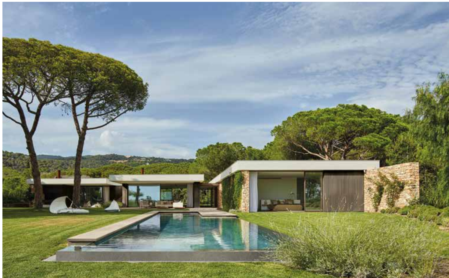
FLOOR SKE2.0 PRIMA MATERIA CENERE 80x80 WALL BOCOTE BAGUETTE 29x120 SWIMMING POOL EDGE PORFIDO 60x120
